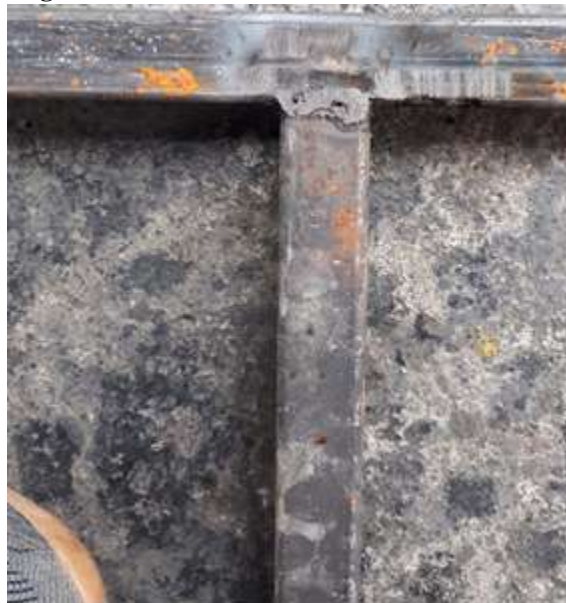
Figura 4: Soldado de una sección de la estructura
