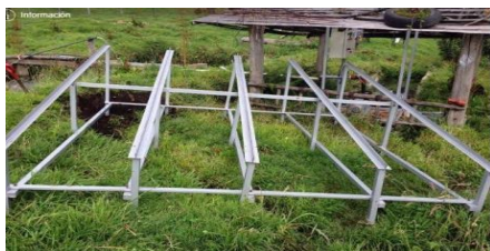
Figura 8. Sistema de mantenimiento
