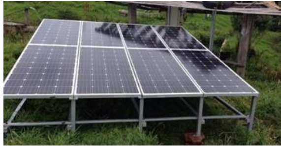
Figura 10. Montaje de los paneles
