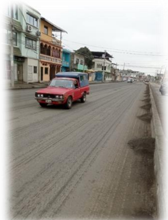
Figura 1. Recolección de Mezcla asfáltica reciclada
