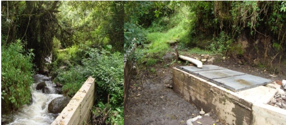
Figura 1. Captación de río Paylahuaico hacia caja reguladora de caudal
